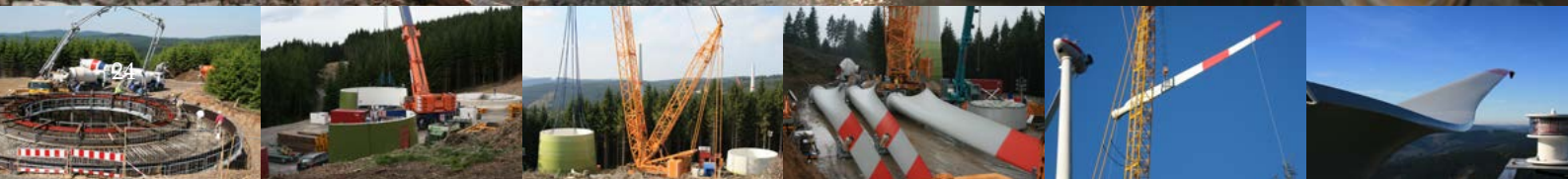
Diverse stappen van de bouw van een windmolen in Windpark Hilchenbach (Duitsland)
